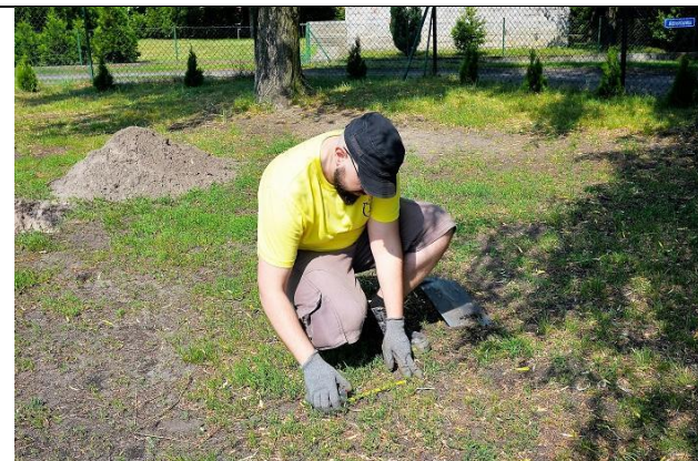
2. Vyměřte velikost základů na povrchu půdy.
