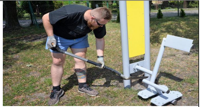
10. Rozsypejte zeminu okolo nosného sloupu a nelepte na něj návod na použití.
