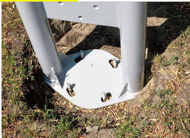
2. Coloque el pilón en las varillas de anclaje roscadas que sobresalen de la cimentación.
