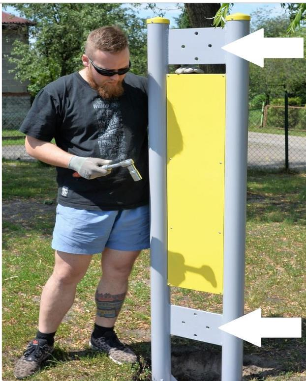
5. Una vez montado el pilón en la cimentación, puede proceder a la instalación del propio dispositivo o de los dispositivos si se van a montar dos dispositivos en el pilón.
