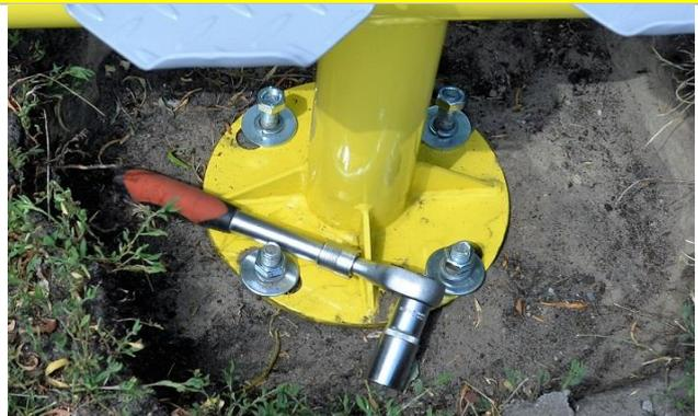
2. Para montar el poste en la cimentación necesita: **4 arandelas lisas galvanizadas (las anchas)**; **4 arandelas de seguridad galvanizadas (las pequeñas)**, **4 tornillos galvanizados Fi 16 mm** y **una llave no. 24**. Todas las arandelas y tornillos se suministran con el dispositivo.
