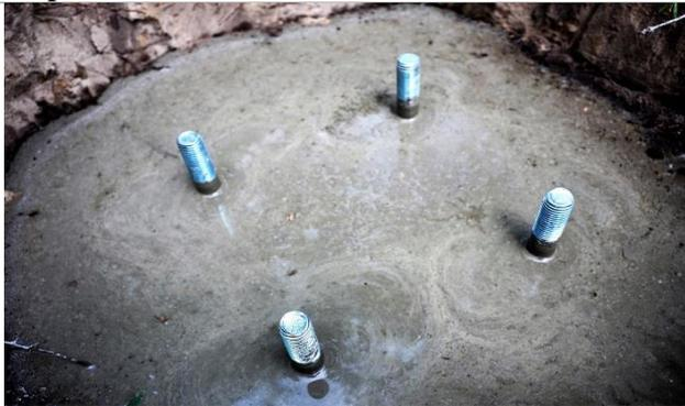
9. Coloque el anclaje en el hormigón de forma **que las varillas roscadas sobresalgan 40-45 mm** por encima del nivel del hormigón y el propio anclaje quede colocado uniformemente en posición vertical. Nivele la superficie del hormigón.
