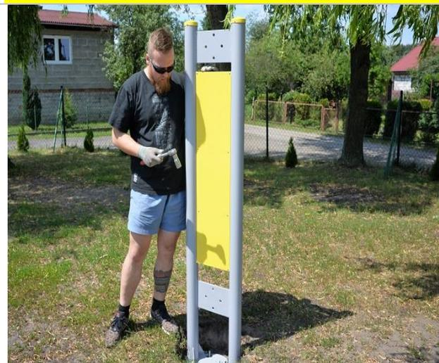
1. Limpie la parte superior de la cimentación y coloque el pilón sobre la base acabada.
