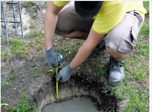
6. Vierta suficiente hormigón **para dejar aproximadamente 100 mm** hasta la superficie del suelo.
