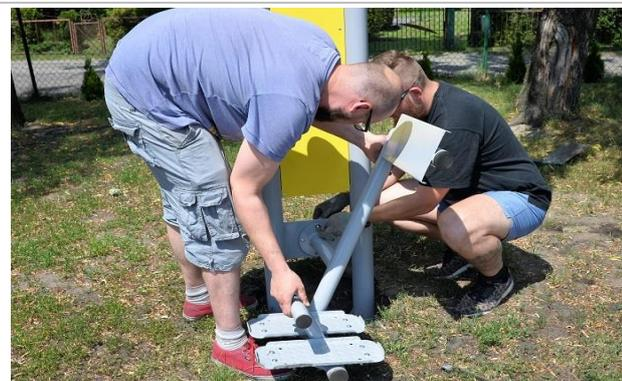
7. Coloque el dispositivo en los puntos de fijación del pilón y fíjelo con un solo tornillo.
