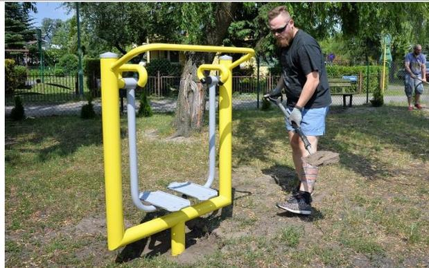
5. Después de apretar los pernos, rellene el lugar de instalación con 150 mm de tierra. Esto es para que el suelo esté nivelado con el resto del terreno.
