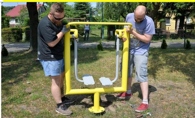
1. Coloque la unidad sobre las varillas roscadas del anclaje de cimentación que sobresalen de la cimentación, para no dañar las roscas.
