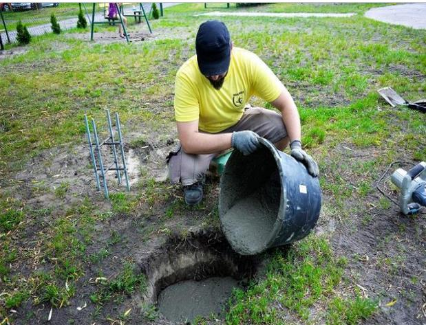
5. El montaje se realiza sobre cimentaciones de hormigón B20 o B25.
