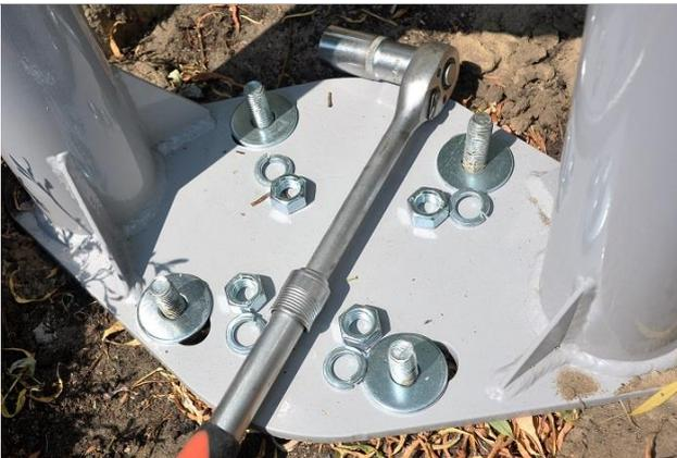
3. Para montar el pilón en el anclaje de cimentación se necesitan **4 arandelas lisas galvanizadas, 4 arandelas de seguridad**
